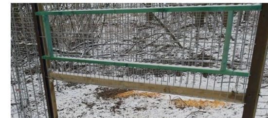
Querelemente schließen unten bündig ab
