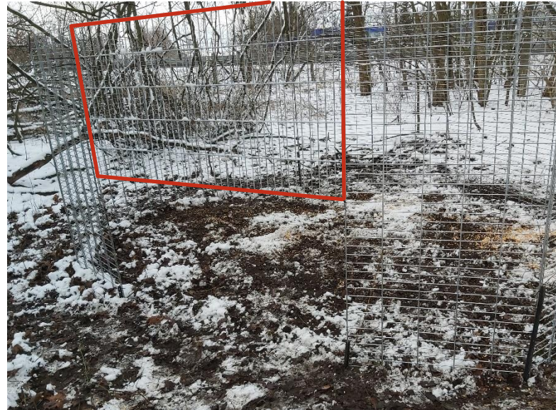
Letztes Element oben quer einbauen
