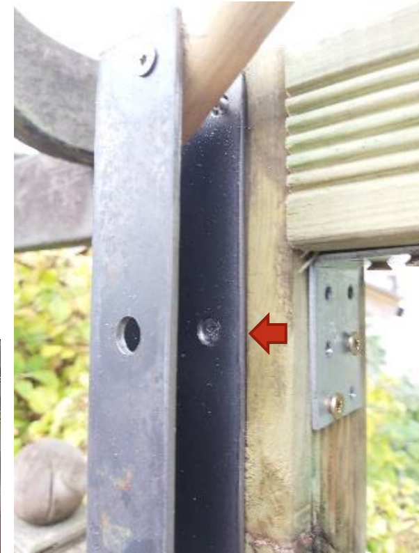
ÖJV BB: Schrauben komplett versenkt
