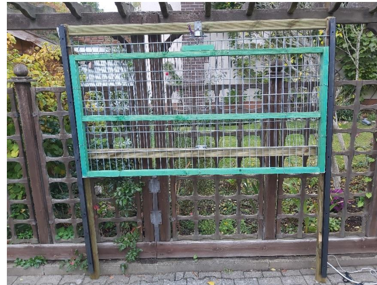
ÖJV BB: Tor läuft in U-Profil
